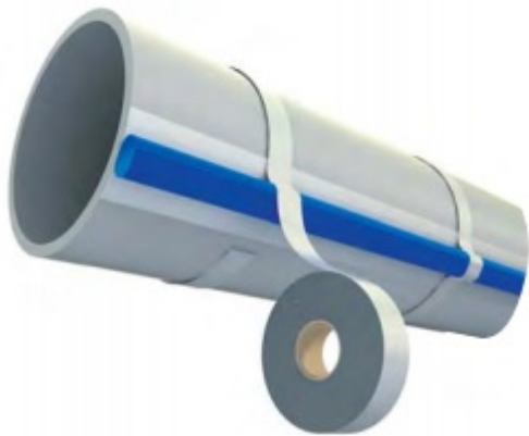
Montaż przewodu na rurze z tworzywa sztucznego
